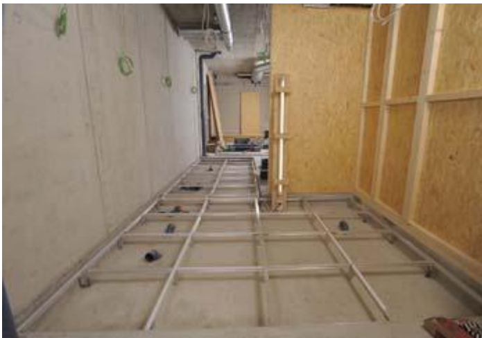
Montage der Duschwannen - Unterkonstruktion, und Duschwannen
