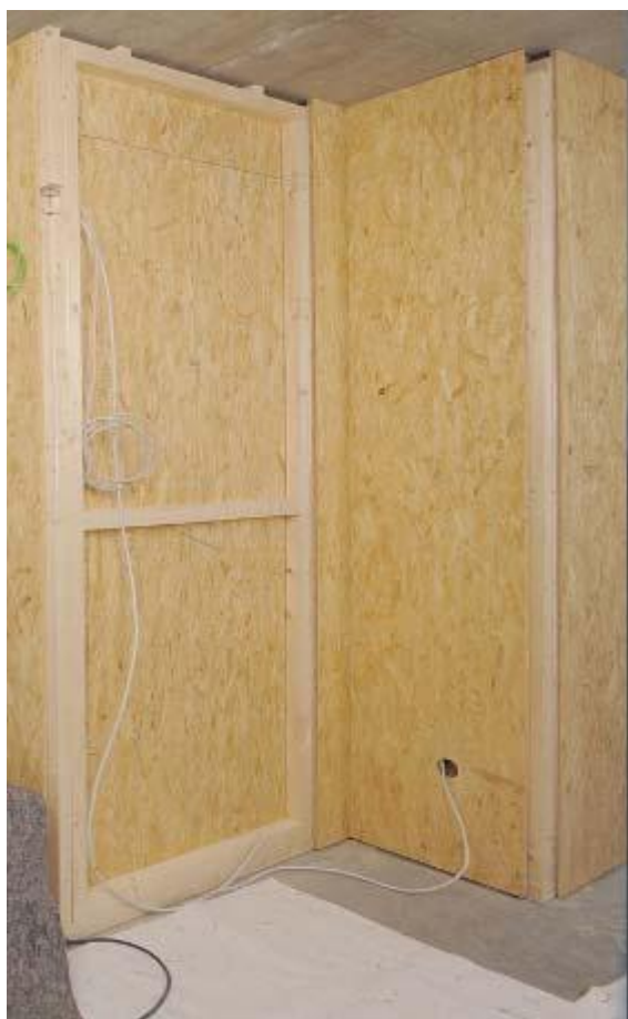
Montage der Trockenbauwände und Einziehen der gesamten Elektroleitungen
