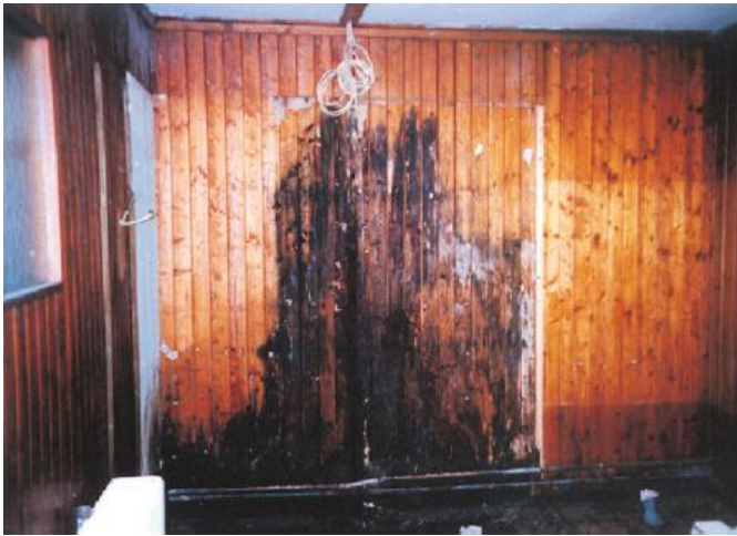
Situation und Ausgangslage vor der Sanierung
