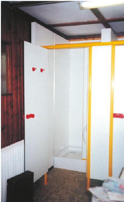
Umsetzung und Optik nach der Sanierung
