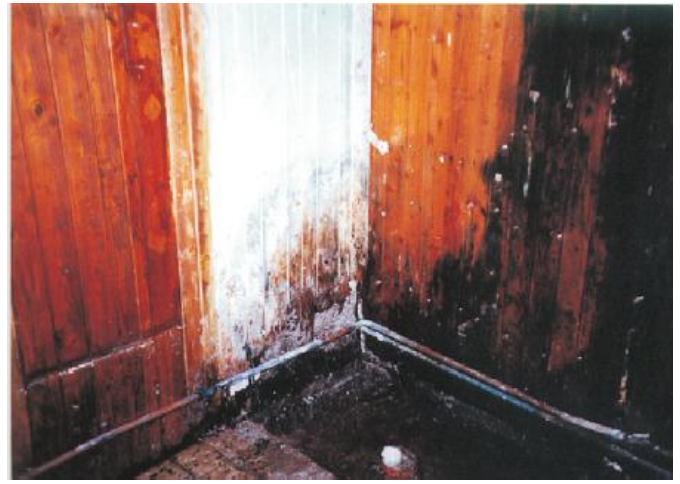
Situation und Ausgangslage vor der Sanierung
