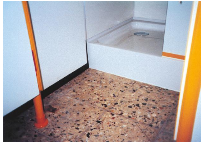
Umsetzung und Optik nach der Sanierung
