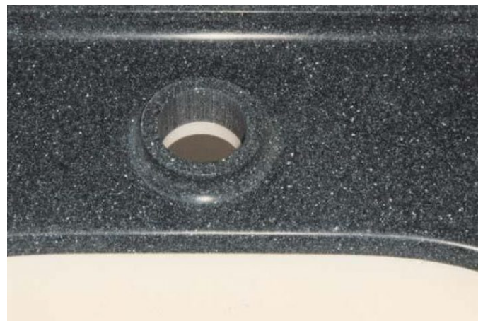
Becken untergebaut mit bündigem Übergang zur Platte.
