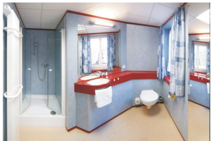
In einem Raum 2 Bäder für 2 Doppelzimmer in unterschiedlicher Optik
