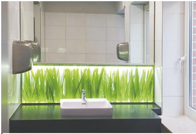
HUG-Gaßte WC mit beleuchteter Nischenrückwand und Spiegel
