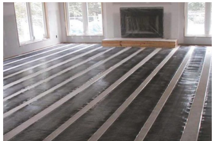
Verlegte Lofec Infrarotbahnen
