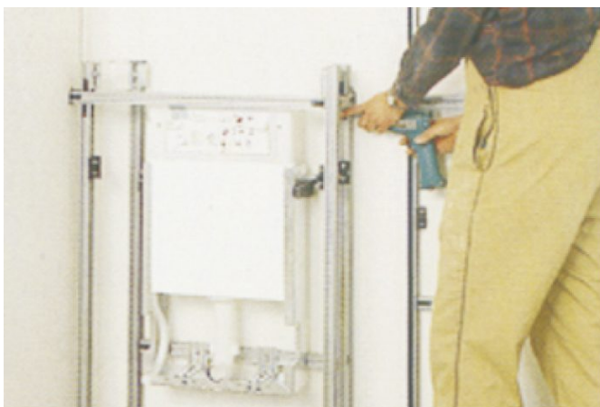
WC – Baustein bei der Rohmontage
