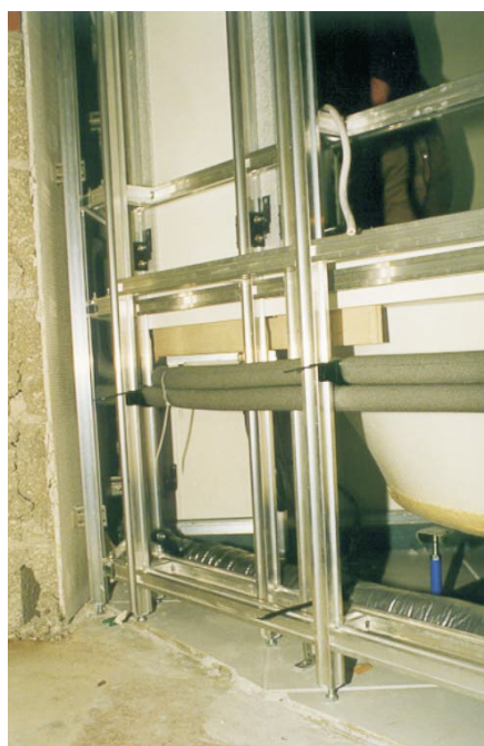
Schallentkoppelung zum Boden
