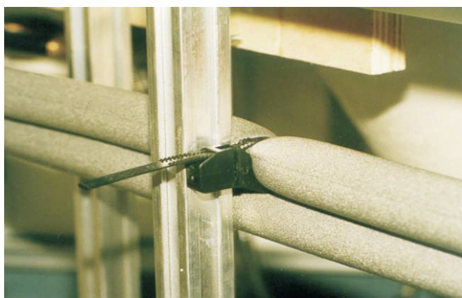
Schallentkopplung von Fliesgeräuschen
