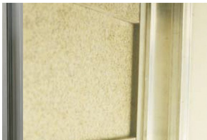
Konstruktive-Hinterlüftung Draufsicht / von oben
